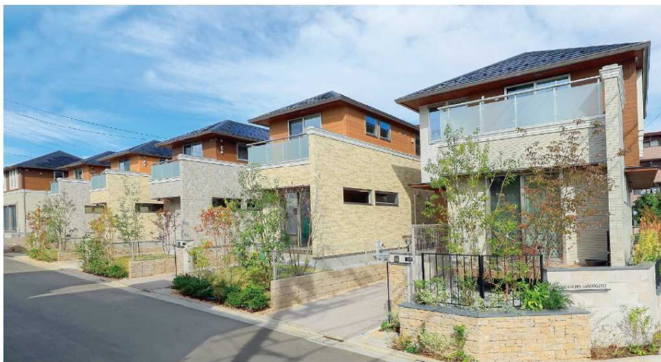
※掲載の写真は現地街並みを撮影(2022年10月)したものです
